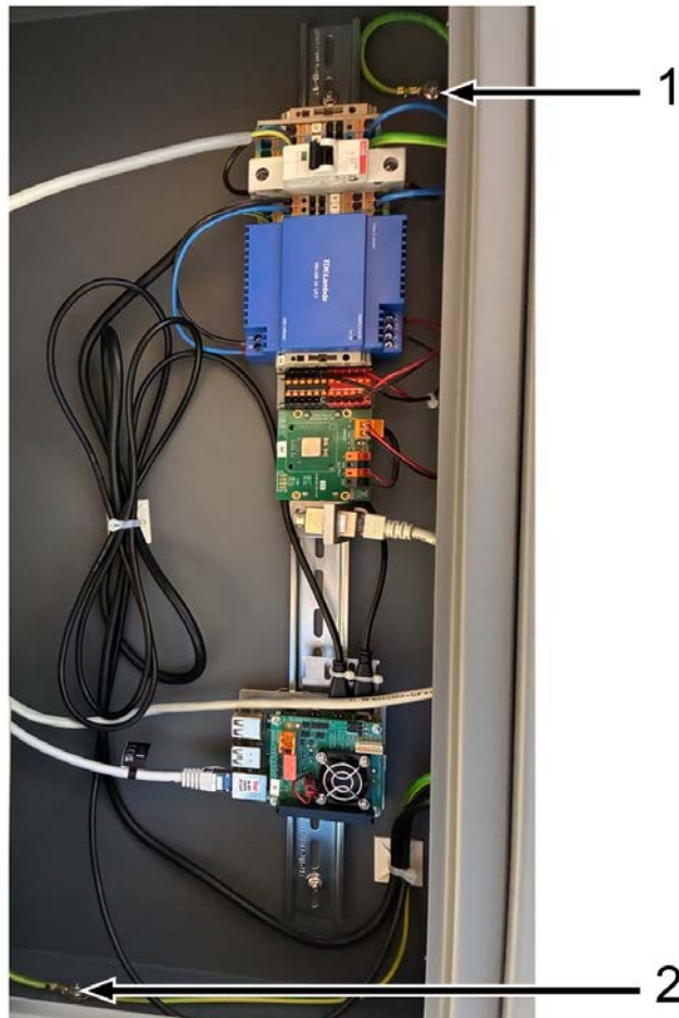
Abb. 18: Messpunkte DIB 600 POST
