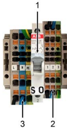
Abb. 9: Klemmleiste -X0
