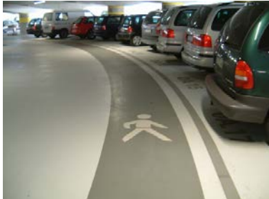
Abb. 1: Sicherheitsmarkierung auf der Fahrbahn
