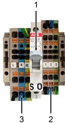
Fig. 9 : Bornier -X0
