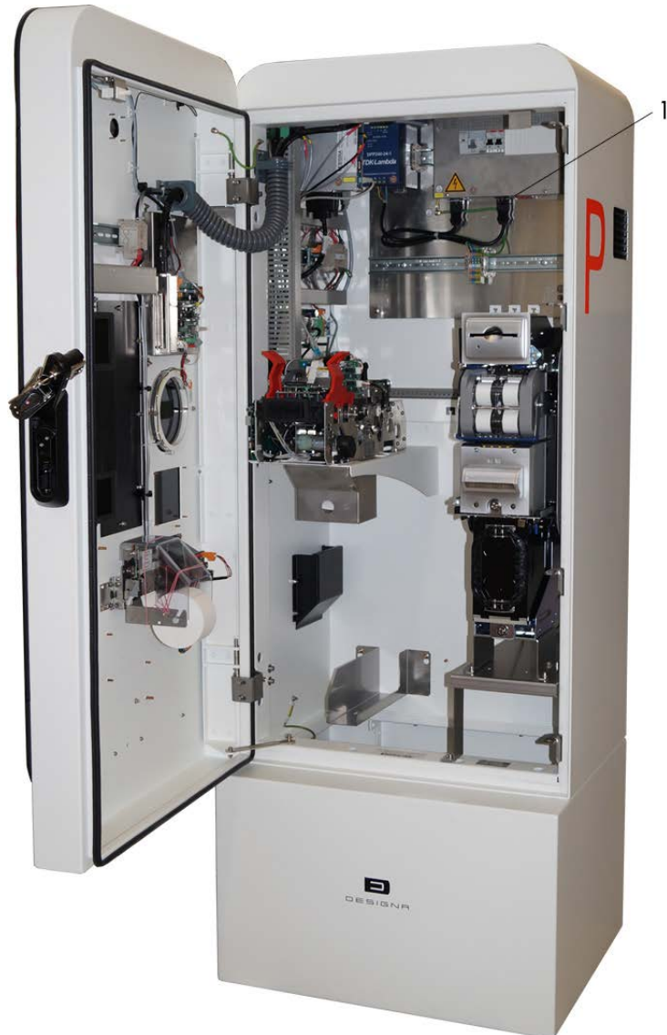
Abb. 39: Messpunkt für die Fehlerschleifenimpedanz-Prüfung
