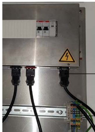
Abb. 21: Klemmleiste -X0
